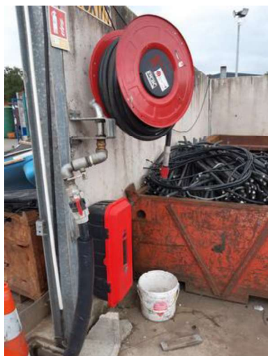
RIA avec étiquette de contrôle datant de 2024
