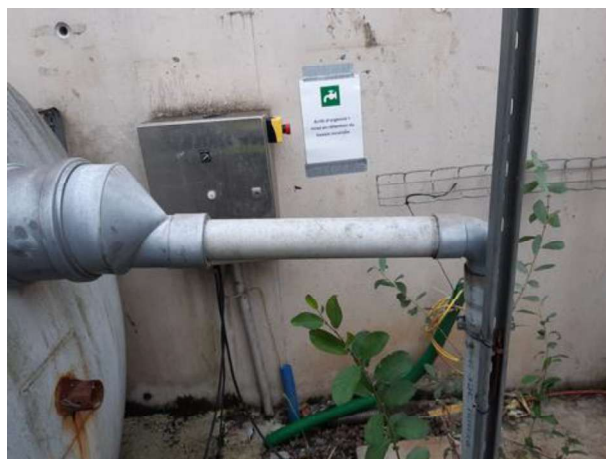
Point de prélèvement en sortie du débourbeur
